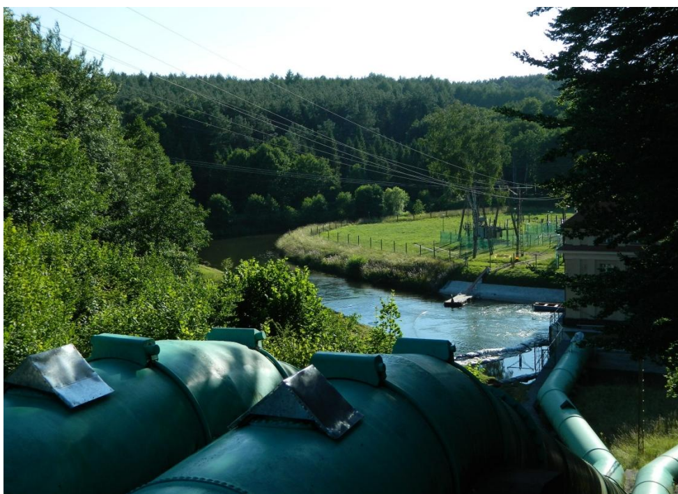
Ryc. nr 42. Przejście linii nad kanałem odprowadzającym wodę z EW Gałąźnia Mała do Słupi (fot. A. Sito).
