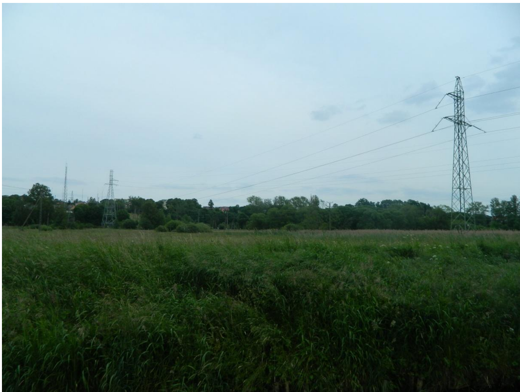
Ryc. nr. 8. Wyprowadzenie linii z GPZ Bytów i przejście nad doliną rzeki Bytowej (fot. A. Sito).
