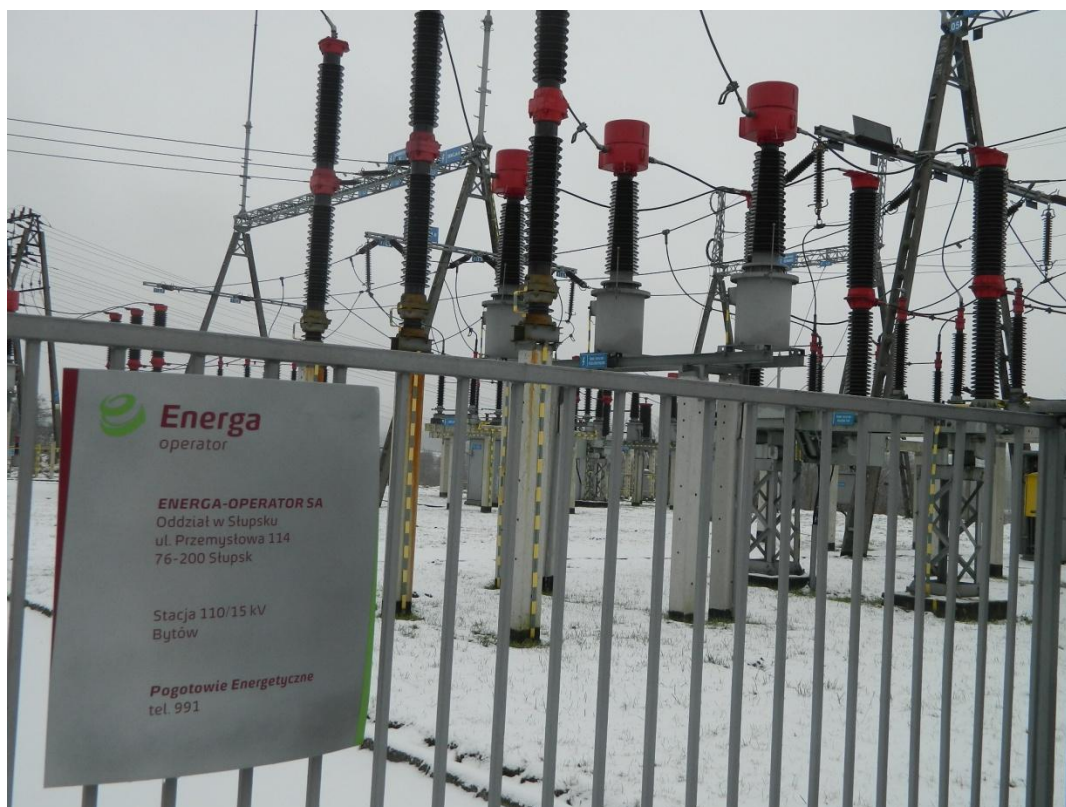
Ryc. nr 7. Stacja GPZ Bytów – początek linii (fot. A. Sito).
