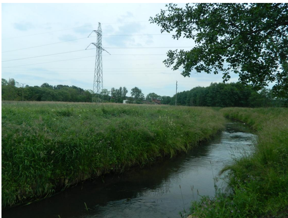
Ryc. nr 37. Przejście linii nad rzeką Bytową (fot. A. Sito).
