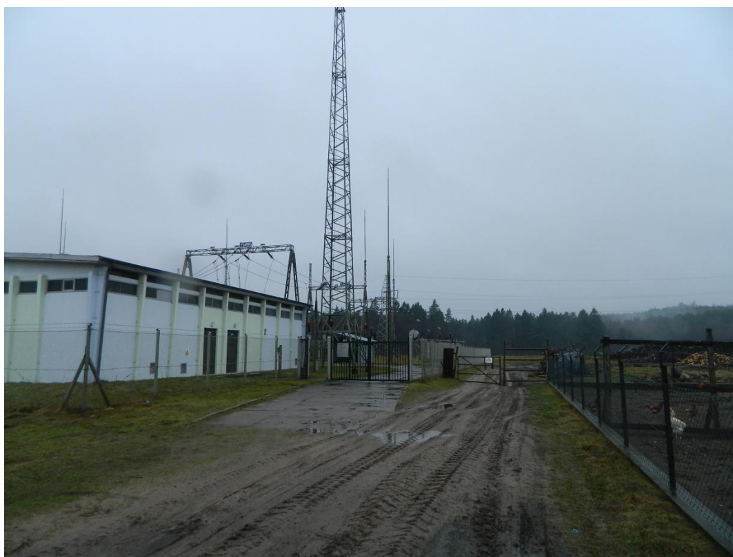
Ryc. nr 13. Stacja GPZ Dębica Kaszubska – zakończenie linii (fot. A. Sito).
