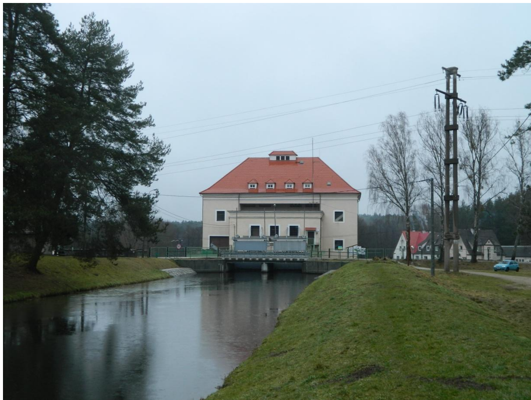
Ryc. nr 8. Przejście linii nad kanałem Słupi i elektrownią wodną w Krzyni (fot. A. Sito).
