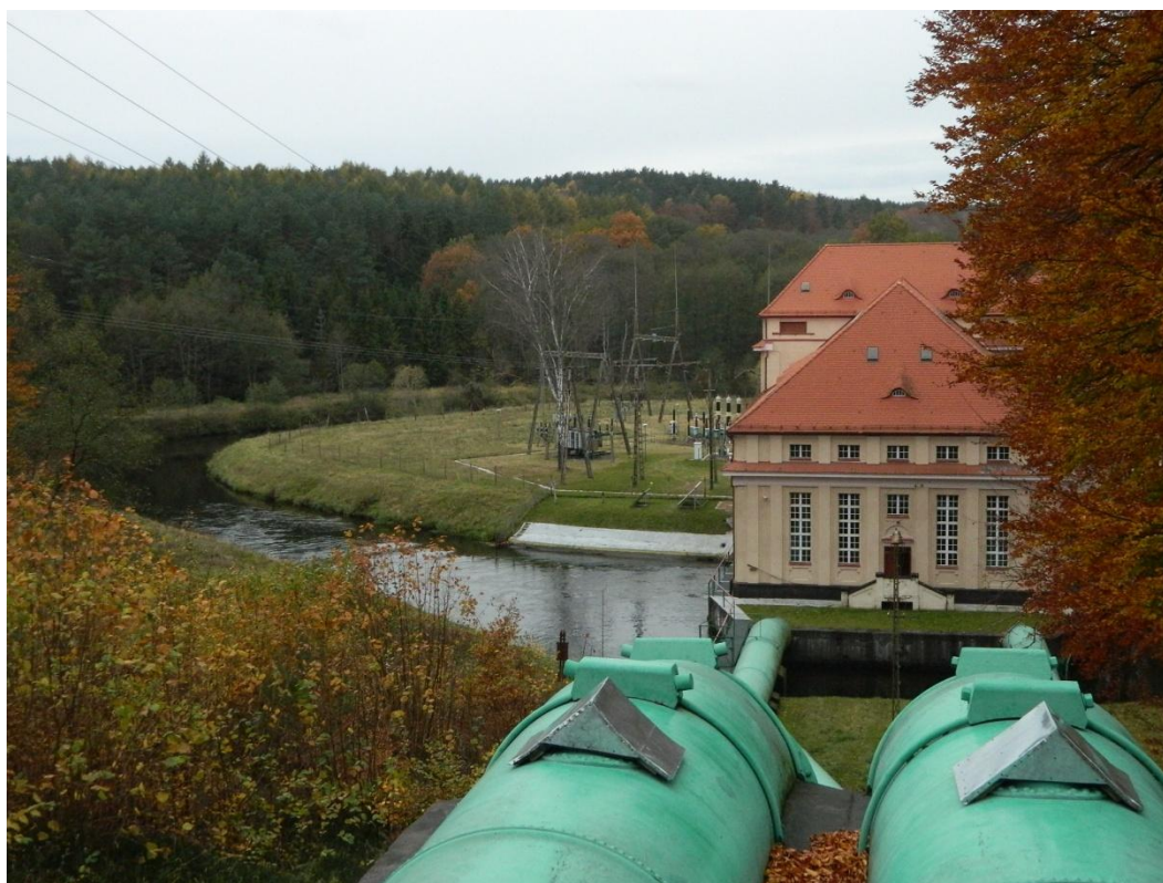
Ryc. nr 7. Elektrownia wodna i stacja GPZ Gałąźnia Mała – początek linii (fot. A. Sito).
