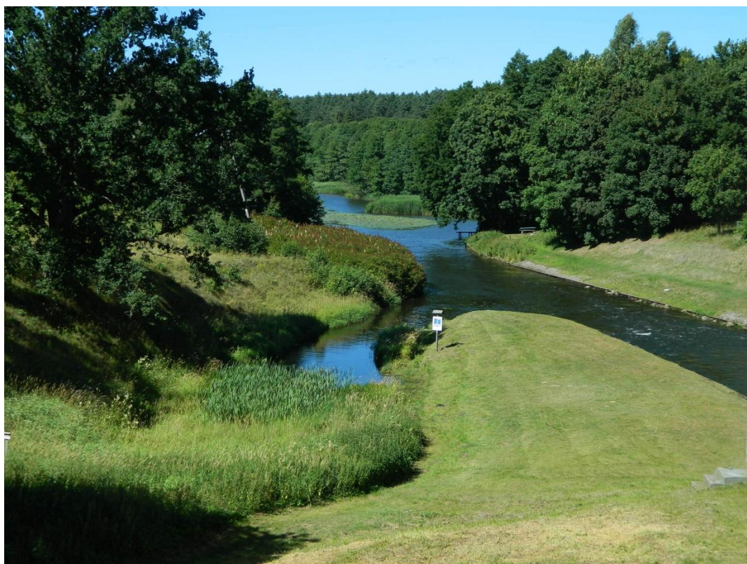
Ryc. nr 9. Widok spod linii na wylot wody z EW Krzynia oraz koryto tzw. „starej Słupi” (fot. A. Sito).
